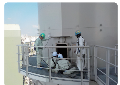
煙突外部劣化診断
