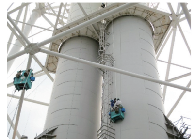
煙突外部ゴンドラ点検
