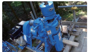
山岳地でのボーリングの様子
