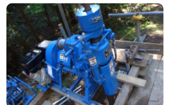
山岳地でのボーリングの様子
