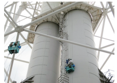
煙突外部ゴンドラ点検
