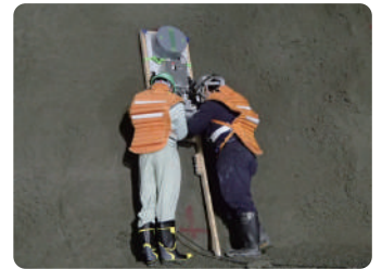
トンネル切羽前方探査
