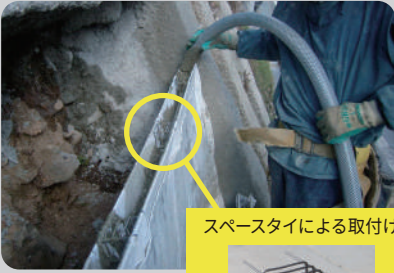
6 カーテンウォールへの注入
