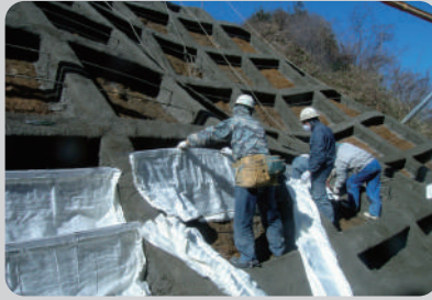
5 カーテンウォールの設置
