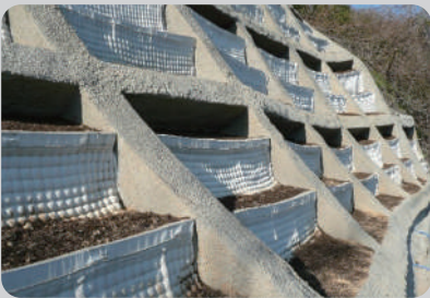
7 カーテンウォールにより枠内処理の完成
