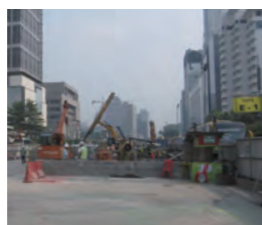
インドネシアでの地下鉄工事
