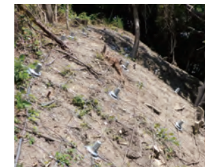
ユニットネット工法による法面保護
