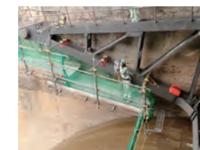
洪水吐ゲート点検
