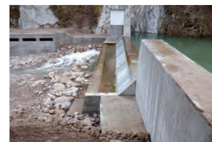
小水力発電所の建設
